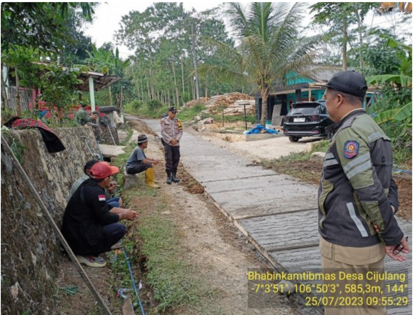
Aipda Sudiro Monitoring Pembangunan MCK di Desa
