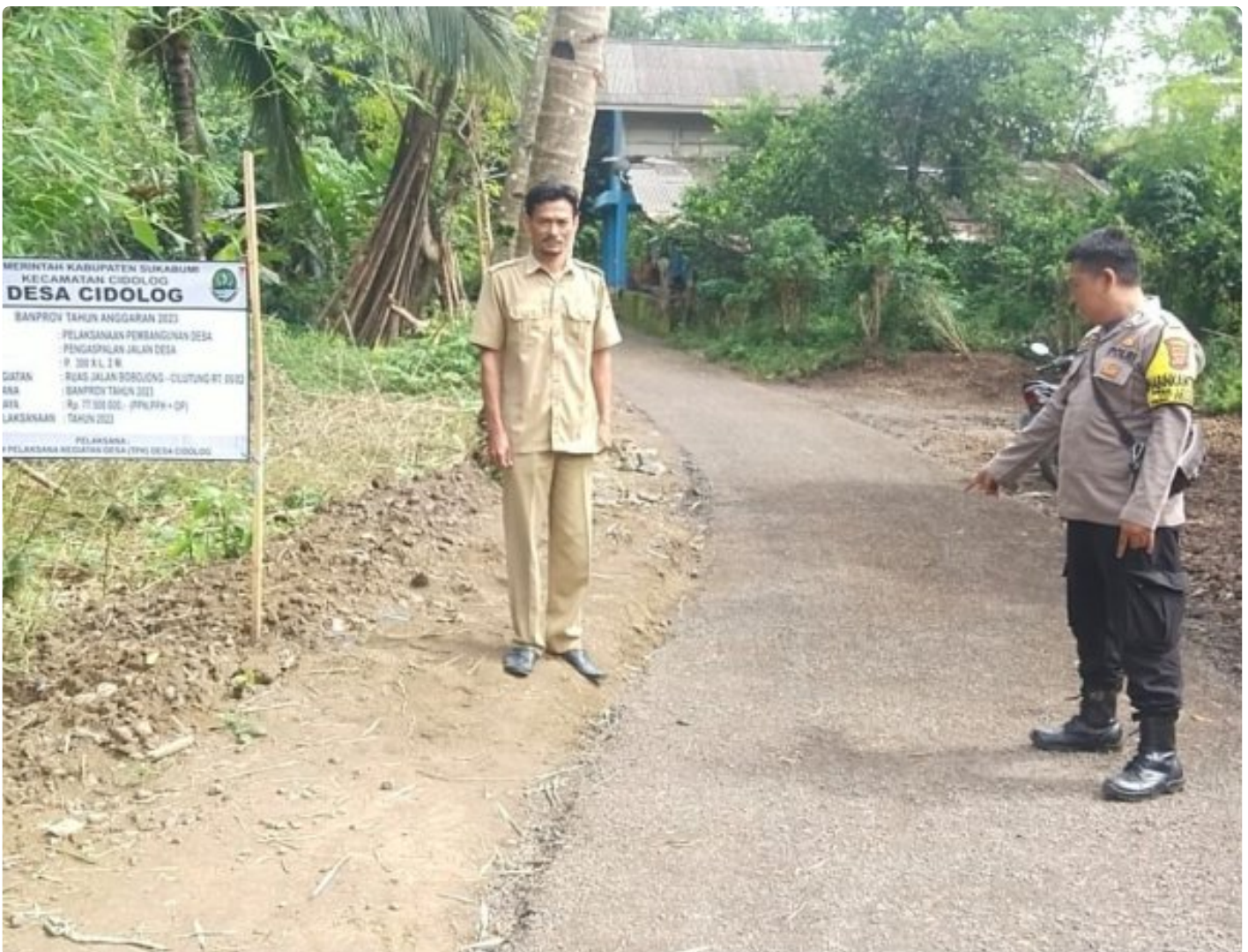
Bhabinkamtibmas Desa Cidolog Awasi Pembangunan Desa
