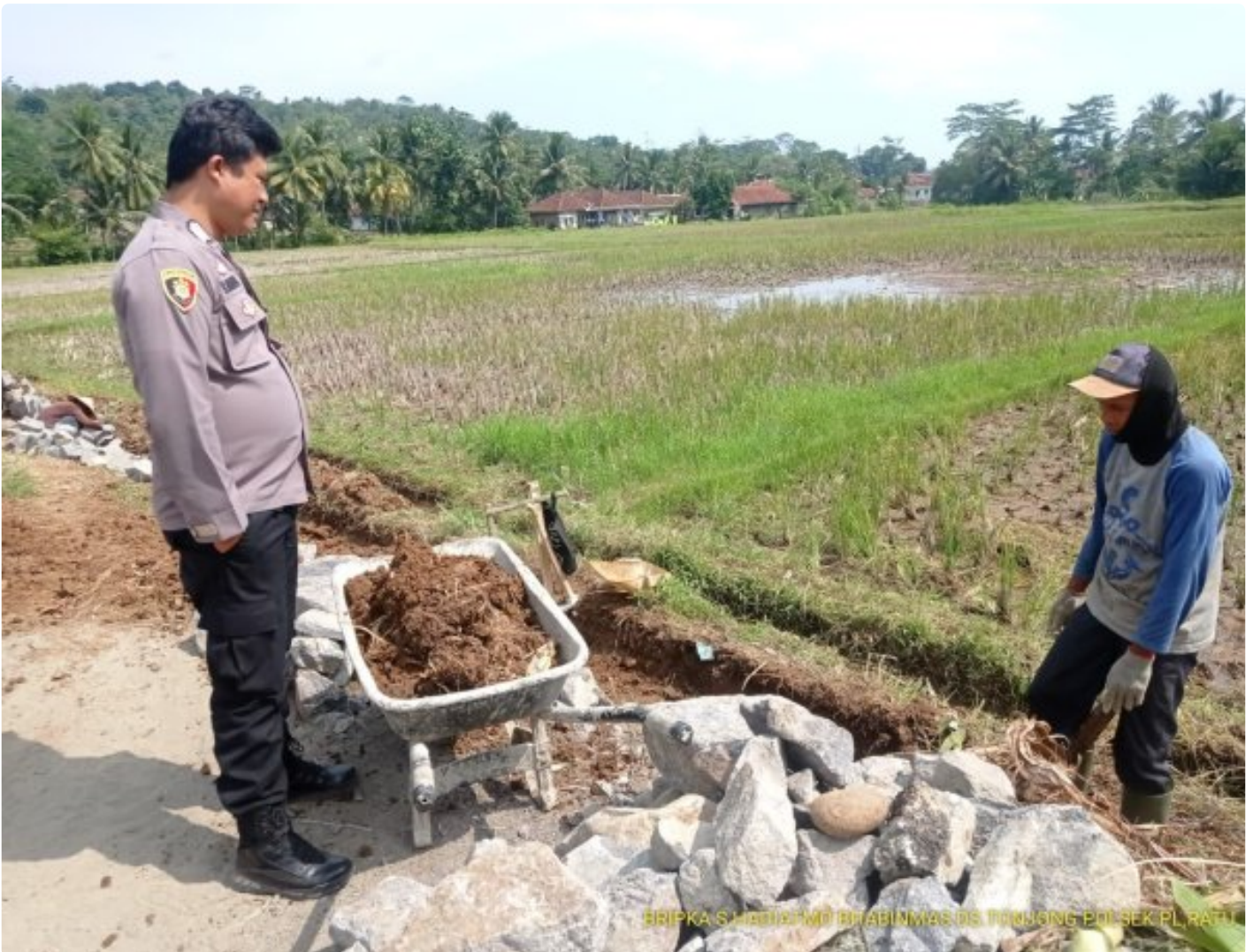
Bhabinkamtibmas Desa Tonjong, Pantau Pembangunan TPT di Desa Binaan
