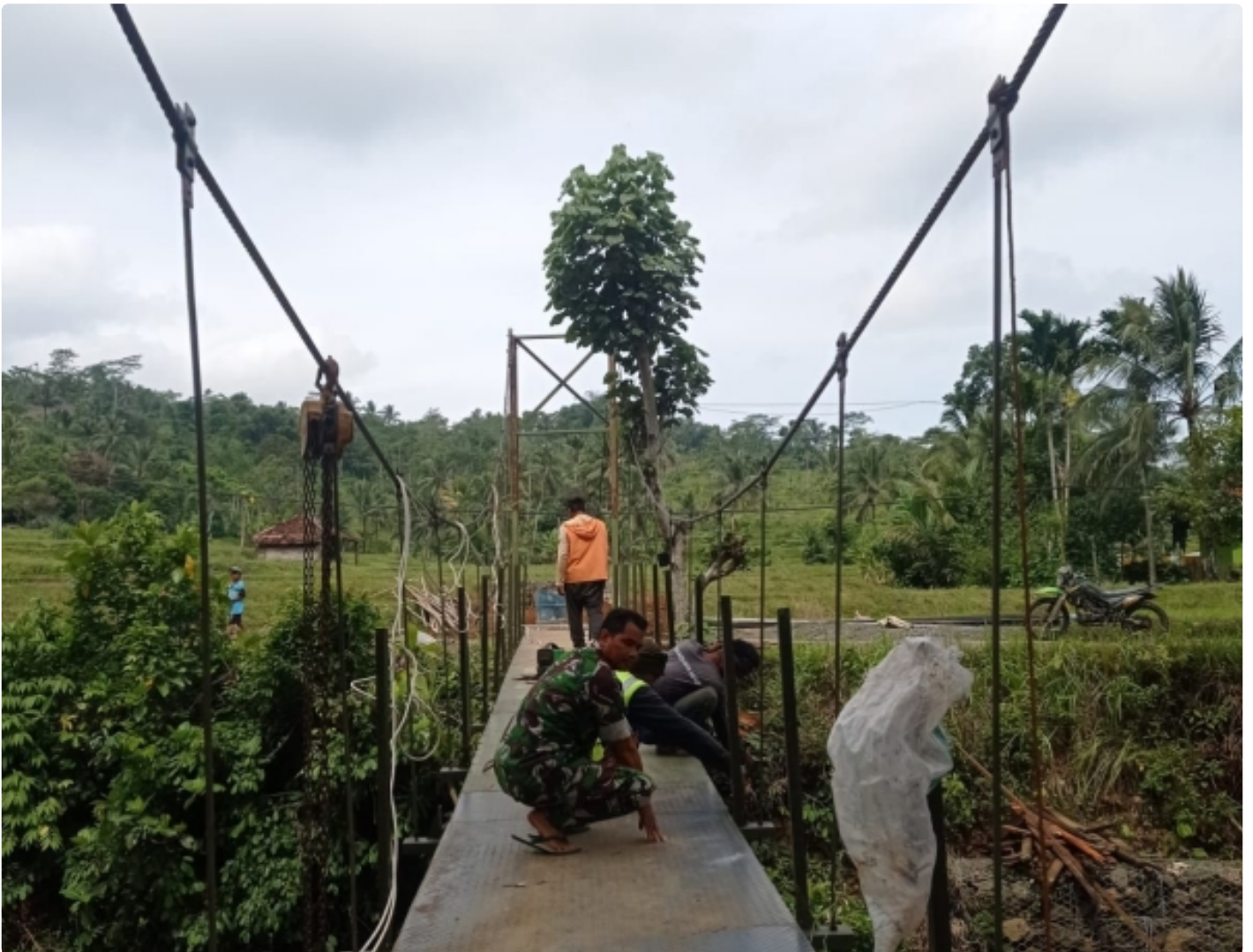
Kpt Arm Witono: Pengerjaan Jembatan Gantung Sudah 80%
